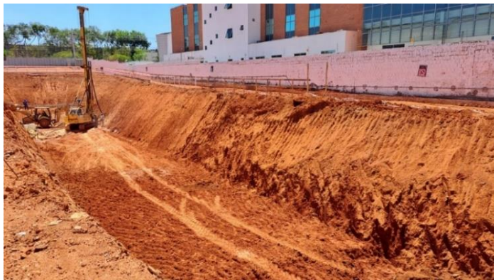
Figura 1. Vista do primeiro horizonte de solo, exposto pela escavação, caracterizado como argila porosa.
