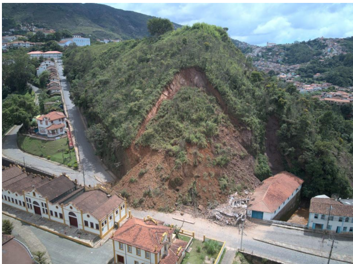
Figura 2: Vista da ruptura do talude do morro da Forca, acessado 20/03/2024 em: https://maisminas.org/ouro-preto-retirada-da-terra-que-caiu-do-morro-da-forca-deve-durar-ate-abril/
