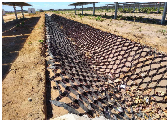
Figura 5. Vista geral de um trecho do canal SN13 que foi removido o revestimento.
