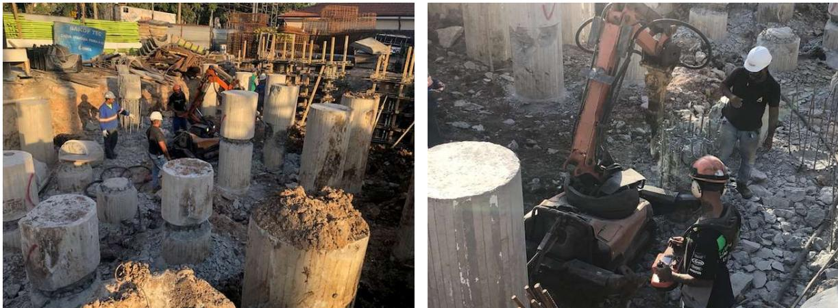
Figura 4: Serviços de demolição dos complementos das estacas
