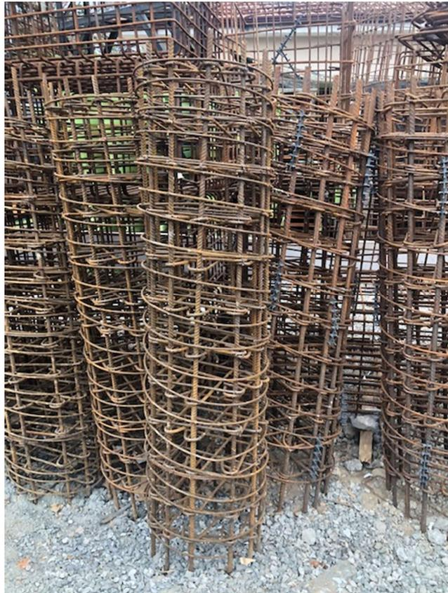
Figura 3: Armadura de fretagem do complemento das estacas
