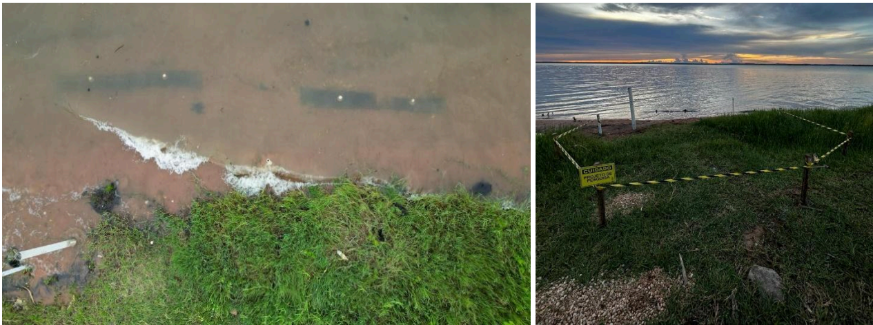
Figura 3. Grupos de tubos de geotêxtil para retenção de areia da praia e proteção de vandalismos.
