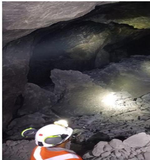
Figura 2: Visita em campo ao local pós ruptura do pilar.
