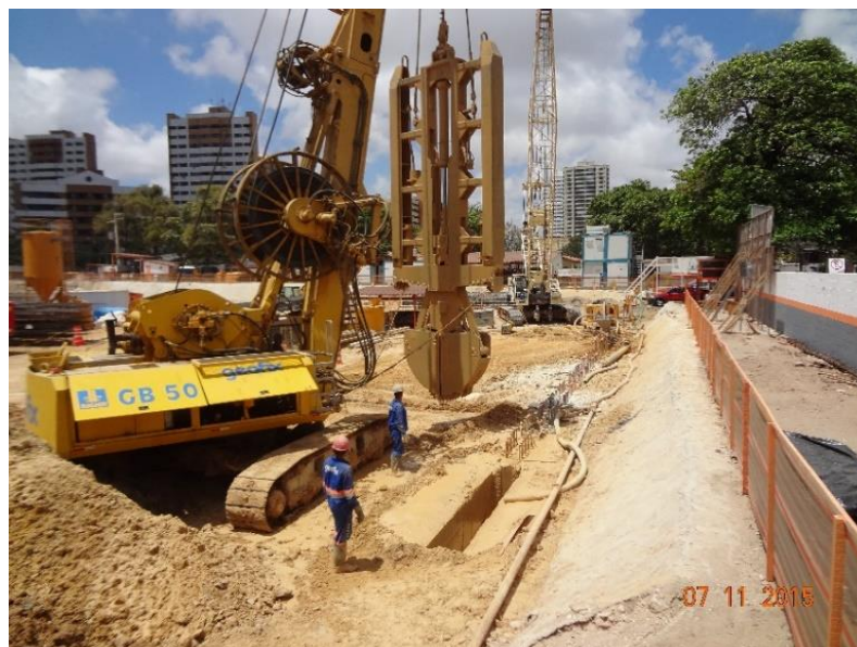
Figura 3. Execução da contenção de parede diafragma com utilização do Clam-Shell no empreendimento (Autor, 2015)
