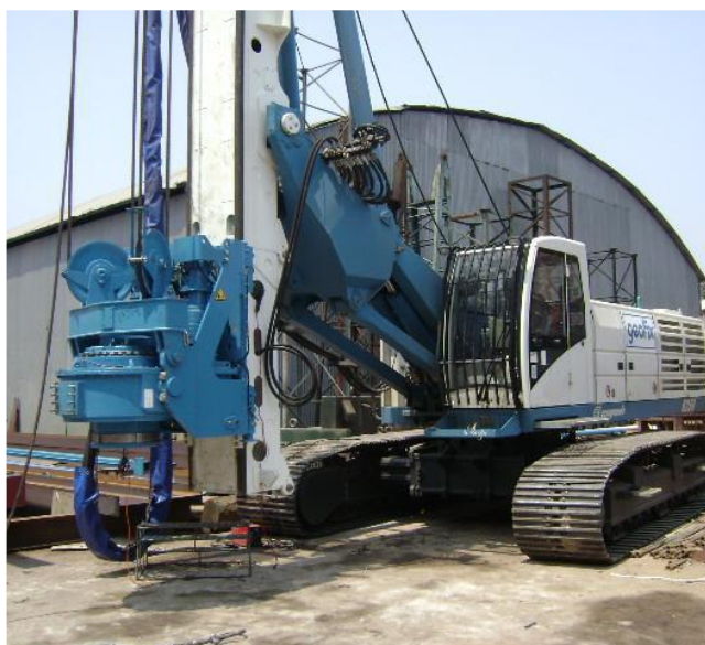
Figura 4. Equipamento perfuratriz utilizado para execução de pré-furo (Autor, 2015)
