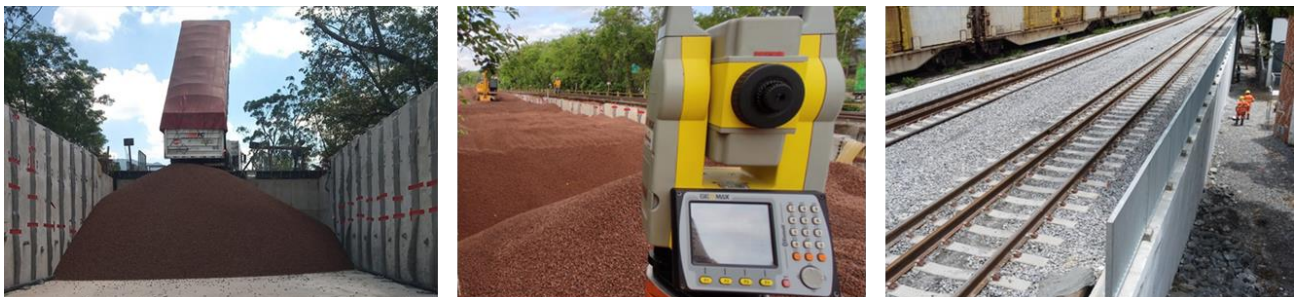
Figura 14. Imagens a) e b) da obra execução e c) em operação
