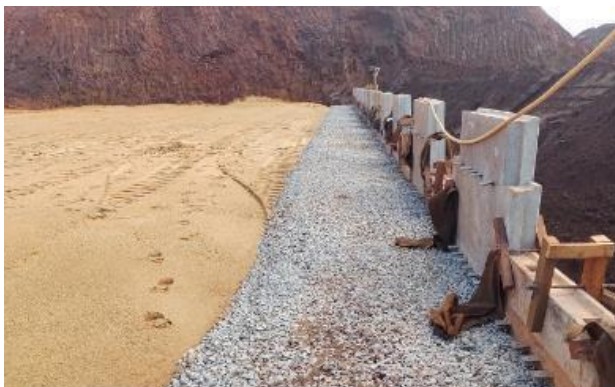
Figura 14 – A cortina de brita compactada no tardo do paramento.
