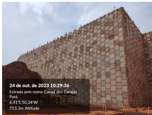
Figura 15 – Vista externa da estrutura já executada em sua seção de maior altura.
