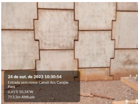
Figura 16 – Vista externa das juntas, após a conclusão total do aterro, exibindo as aberturas mínimas (>15mm) preservadas.
