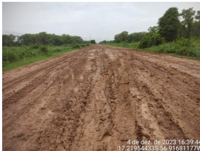
Figura 1. Trecho da rodovia transpantaneira, Fonte: Arquivo pessoal (2023)
