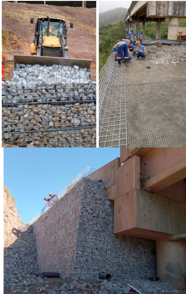
Figura 1. Execução dos muros 13, 106 e 221.
