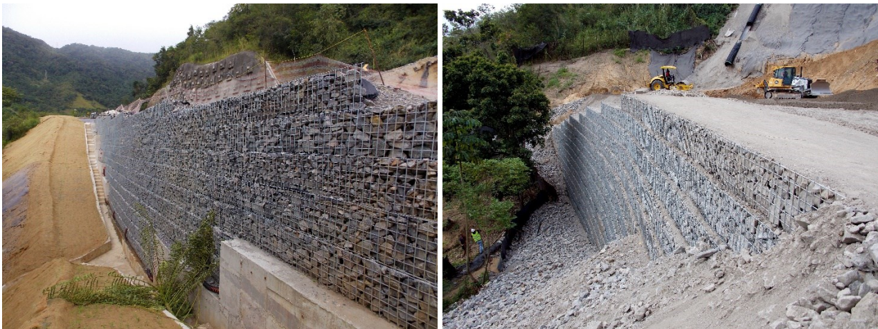
Figura 2. Execução dos muros 18 e 13.
