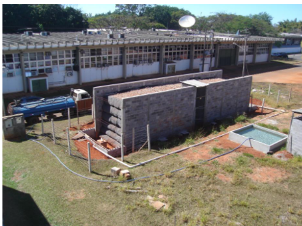
Figura 4. Visão do sistema de inundação da base dos muros experimentais (Santos, 2011)
