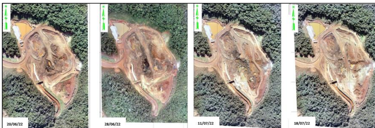
Figura 9. Desenvolvimento das obras para descaracterização – Imagens aéreas
