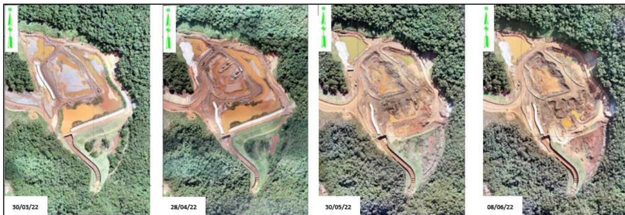
Figura 8. Desenvolvimento das obras para descaracterização – Imagens aéreas
