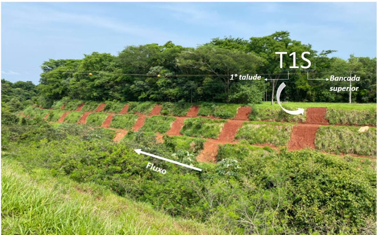
Figura 4. Vista do trecho do canal da Piracema mapeado, com as bancadas preparadas para o mapeamento e exemplo da codificação aplicada.
