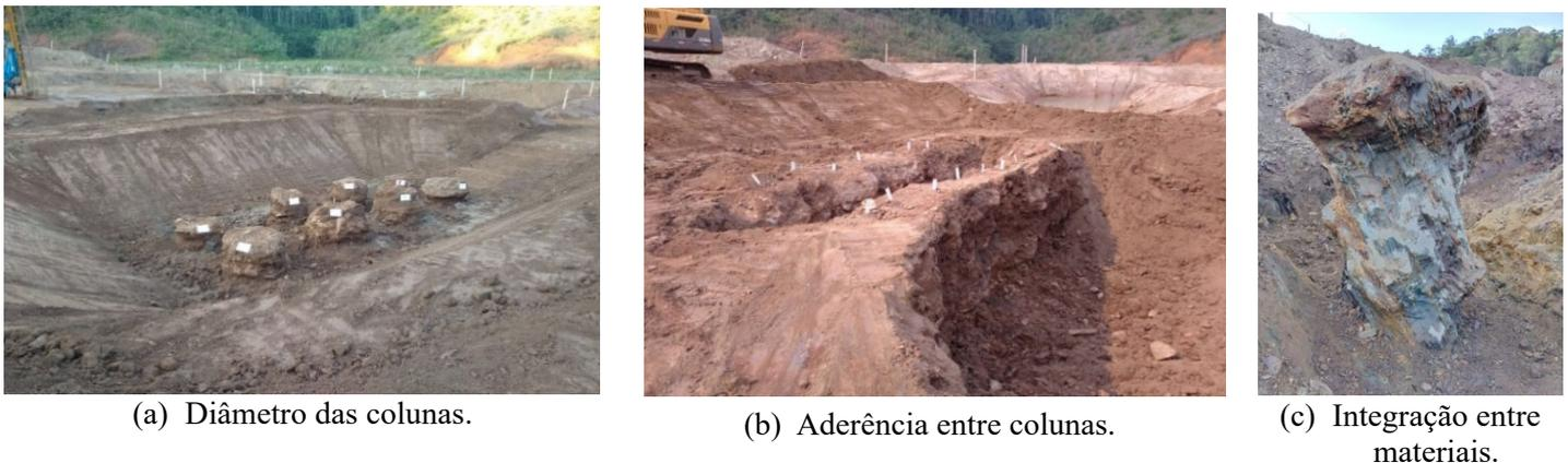
Figura 3 – Verificação das colunas teste.
