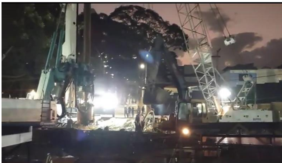
Figura 5. Imagem da obra no período noturno durante uma concretagem.
