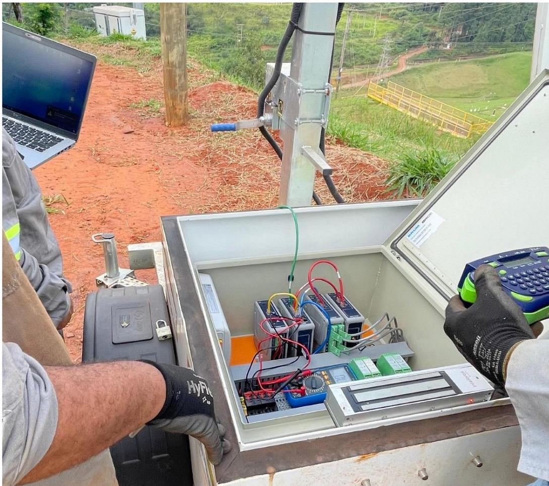
Figura 1. Atividade de campo realizada para comissionamento de rede da instrumentação sísmica presente em uma barragem de mineração. Na imagem é possível notar os componentes eletrônicos do sistema microssísmico que ficam armazenados numa carretinha. (Imagem do autor, 2024).
