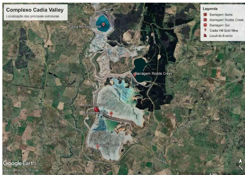
Figura 2. Localização das principais estruturas do complexo de Cadia.
