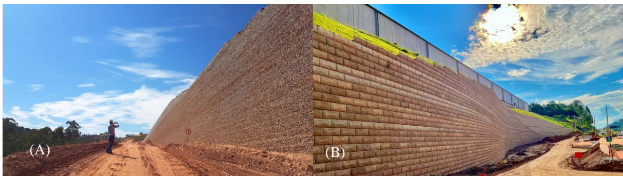
Figura 1. Estruturas de contenções reforçadas com geogrelhas na cidade de Cajamar SP em 2021.
