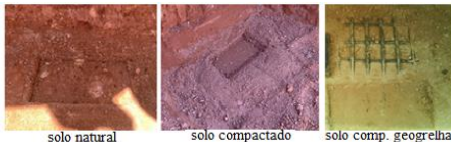
Figura 6. Cavidades (recalques) finais após realização das três provas de carga.
