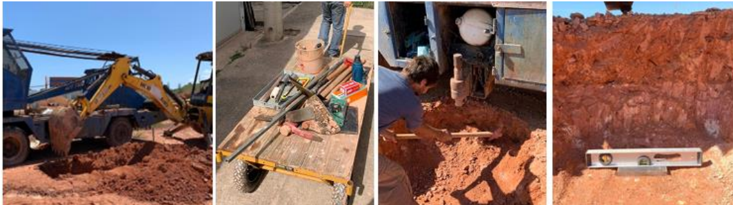
Figura 4. Sequência de execução das cavas para assentamento da placa nas provas de carga.
