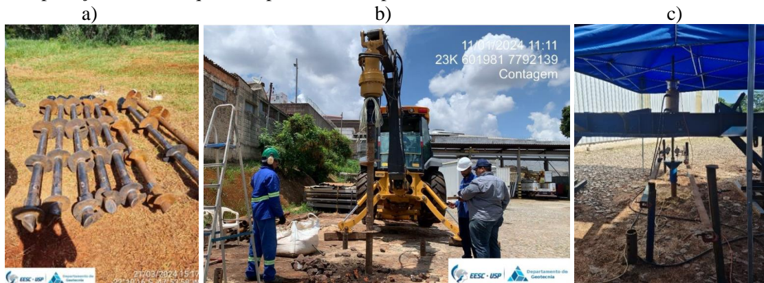
Figura 1. Estacas helicoidais (a), instalação (b), e prova de carga à tração (c).
