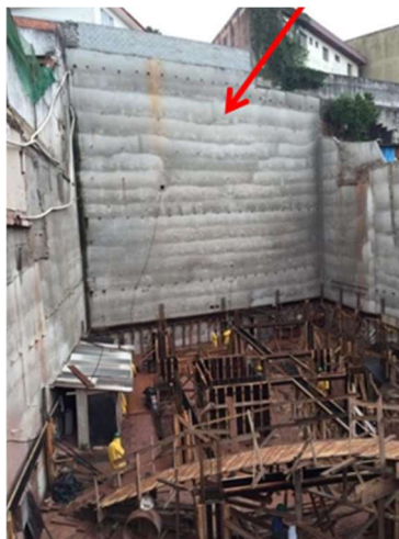
Figura 1. Faces de escavação estabilizadas com solo grampeado (Corte, 2017).
