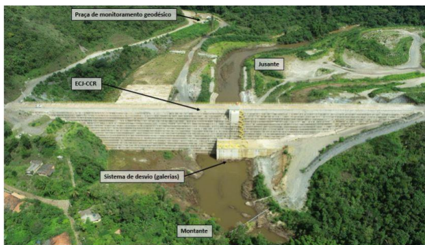
Figura 1. Visão geral da ECJ-CCR. Visada aérea de montante para jusante.
