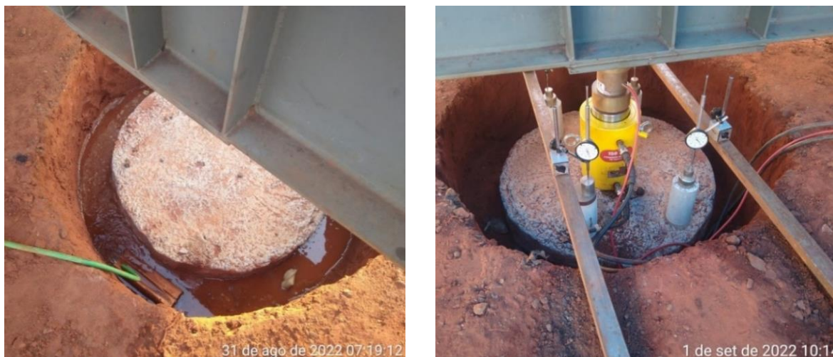
Figura 2. Prova de carga em sapata isolada com solo em estado inundado.
