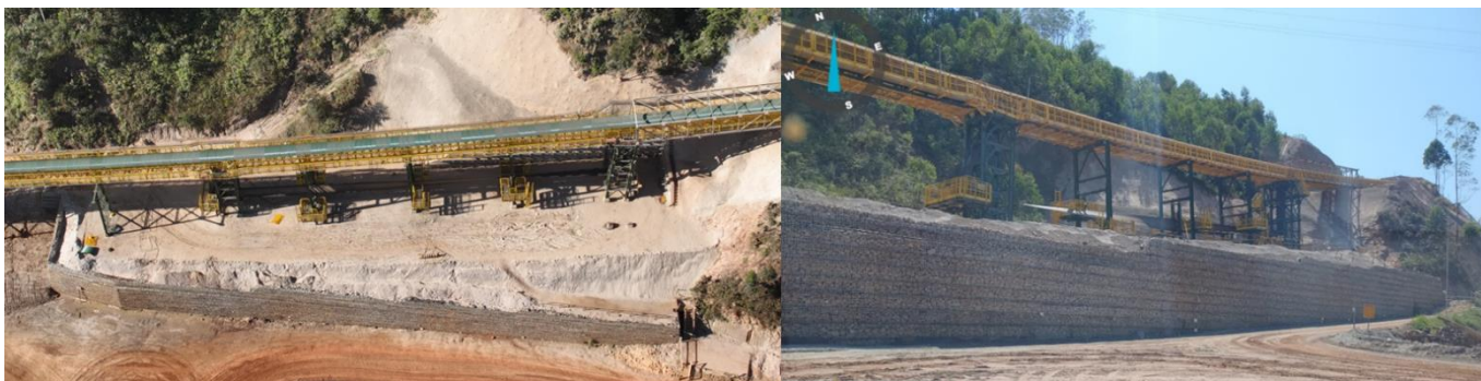
Figura 8: Contenção implantada com TCLD
