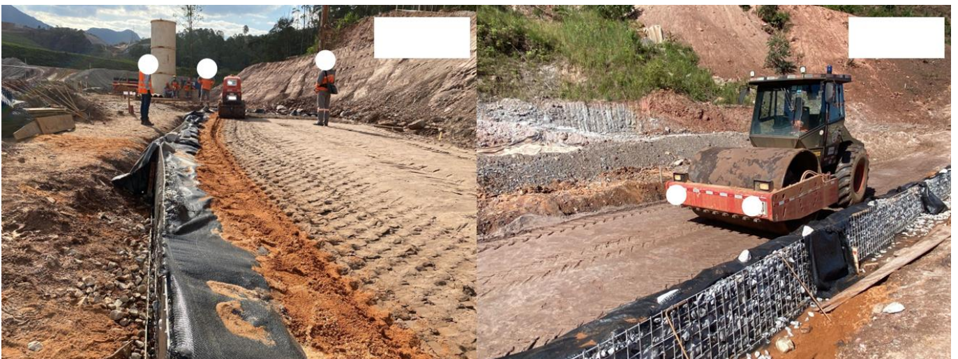
Figura 7: Compactação das camadas de rejeito arenoso: mini-rolô (vibratório) remoto (à esquerda) e rolo liso vibratório (à direita)
