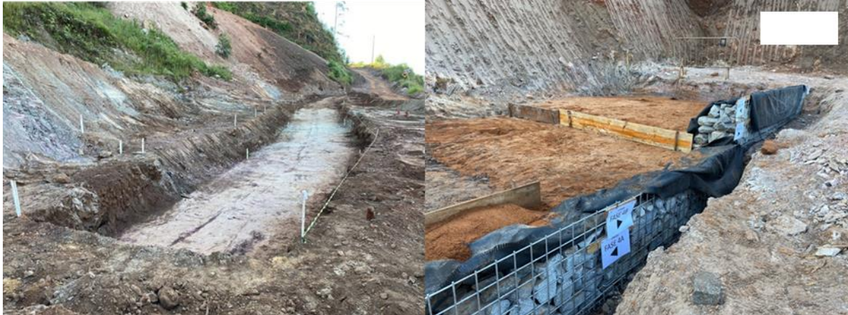
Figura 5: Escavação da fundação: escavação da primeira camada (à esquerda) e escavação de camadas acima dos alteamentos realizados (à direita)
