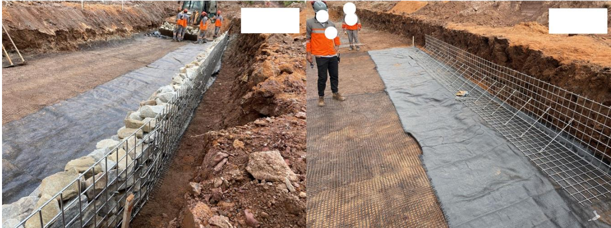
Figura 6: Posicionamento do elemento de face: tela metálica em “L” (à esquerda) e preenchimento com rachão (à direita)
