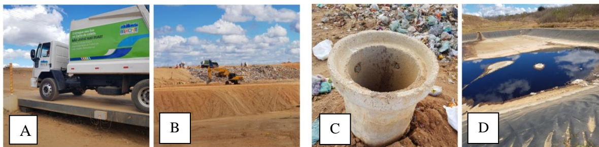
Figura 5. A: Pesagem dos resíduos sólidos urbanos. B: Células de RSU. C: Dreno para queima do biogás. D: Lagoa de tratamento de lixiviados. Fonte: Autores (2021)
