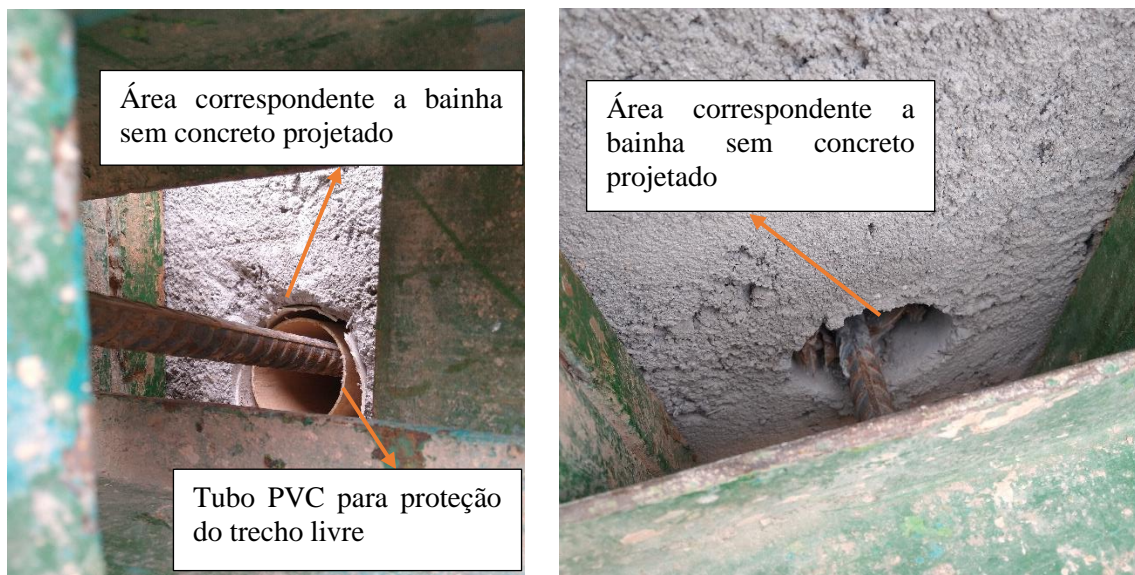
Figura 1. Detalhe do apoio/reação, para o ensaio de arrancamento
