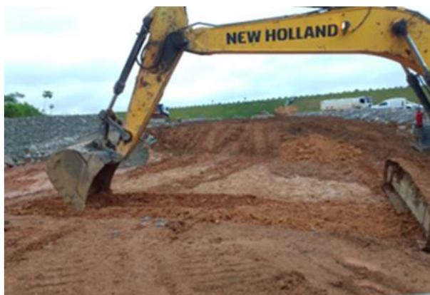
Figura 3. Início da execução da trincheira para coleta de amostras.
