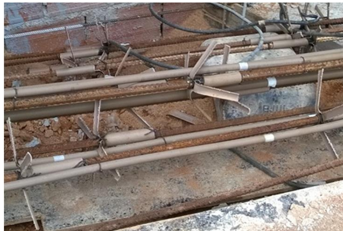
Figura 2. Montagem das barras com os centralizadores e tubos de injeção.
