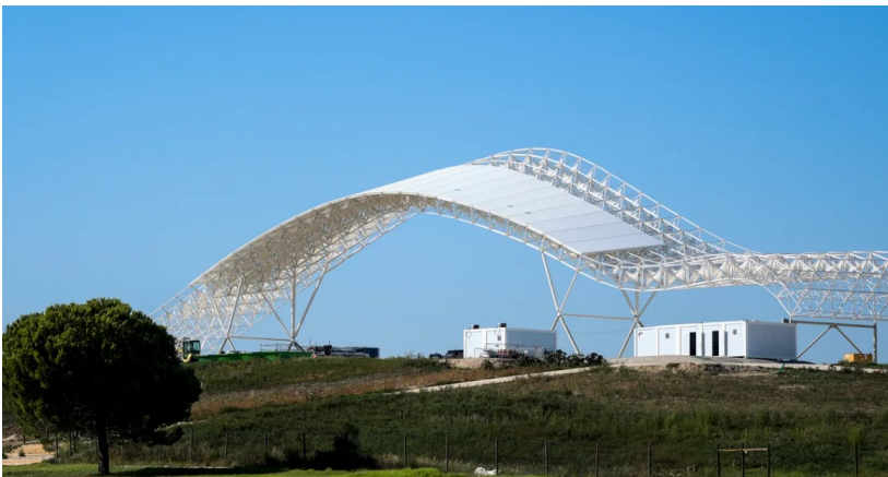
Figura 3 - Vista da cobertura do palco. (Fonte: Observador)
