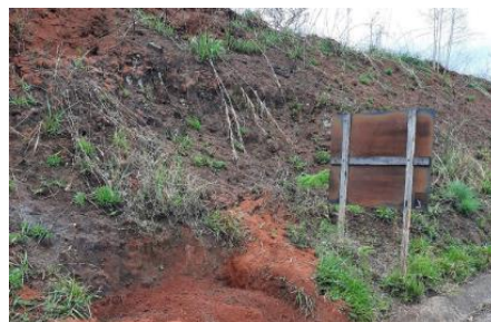
Figura 1. Talude em estudo (16/10/2020).
