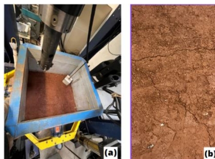
Figura 4. Preparação do sublastro na Box Test: (a) Camada compactada (b) Detalhe da camada após compactação
