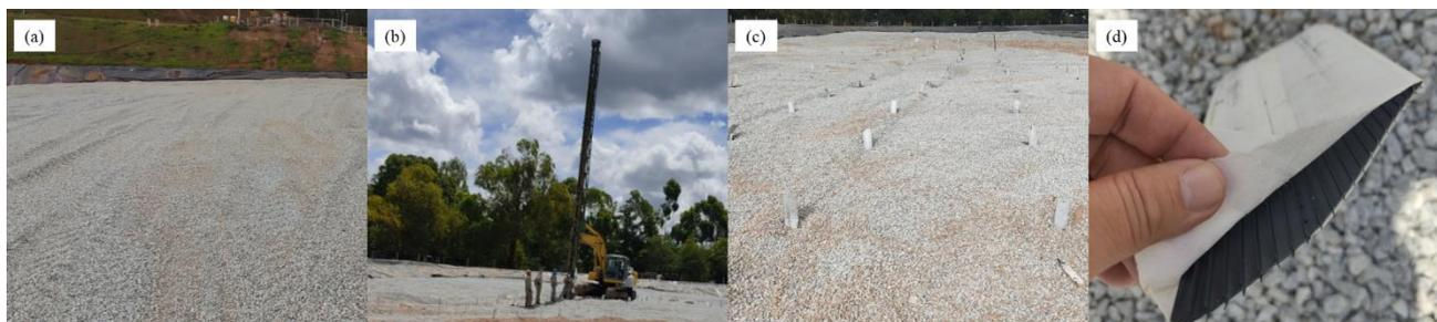
Figura 3. (a) Colchão drenante construído com espessura de 30 cm. (b) Processo de cravação dos drenos. (c) Malhas quadradas com espaçamento de 2,0 m (d) Detalhe do núcleo e do filtro do dreno.
