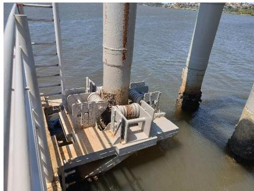
Figura 16. Sistema de apoio e transferência de carga entre o flutuante e as fundações – detalhe em Porto de Santana/Cariacica
